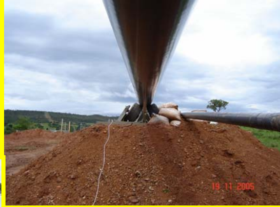
Montagem da Coluna
