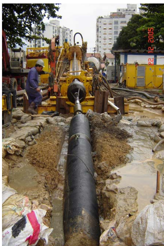
Detalhe do Barrel Reamer e Tubo Instalado
