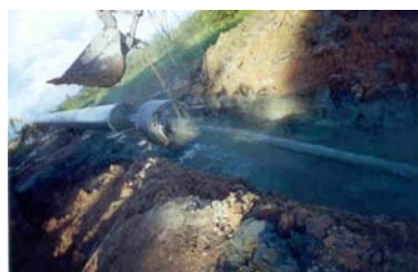
Preparação da coluna e Início do Puxamento
