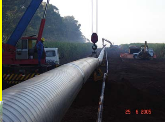
Montagem da Coluna
