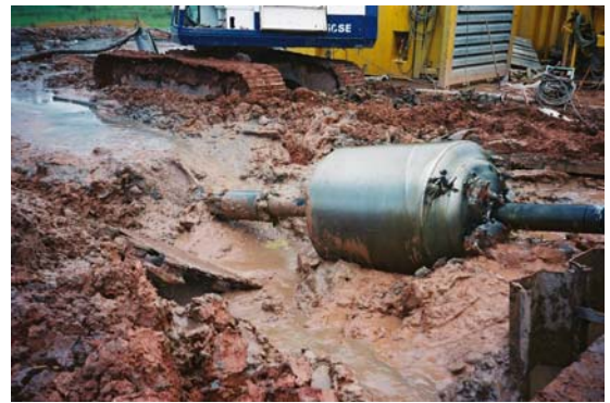
Chegada da Tubulação - Tubo Instalado
