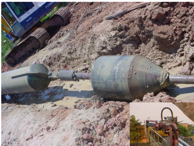
Detalhe do início do puxamento com "barrel reamer" a frente da tubulação.
