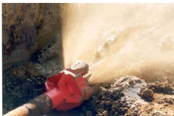
Detalhes do Início do Alargamento
